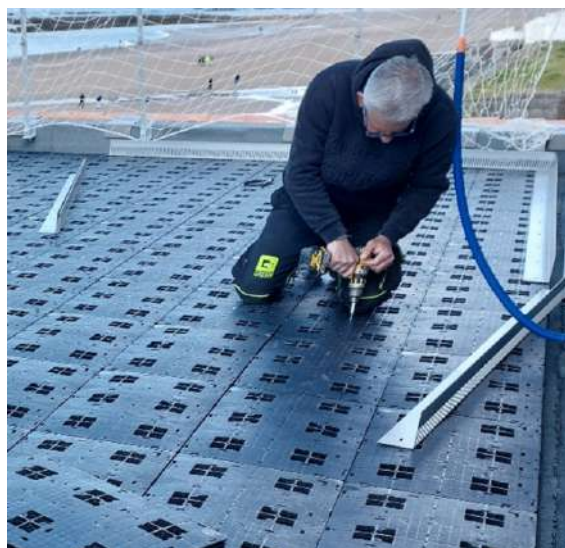
Figure 28. Fixation des équerres métalliques en L sur les plaques MODULO
