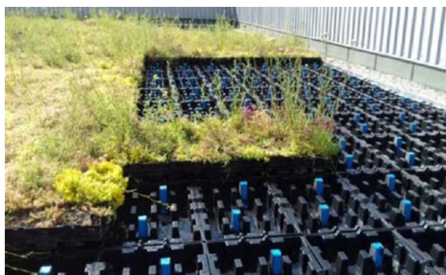
Figure 1. Version OASIS® GREEN PACK avec bac HYDROPACK® sur bac HYDROSTOCK
