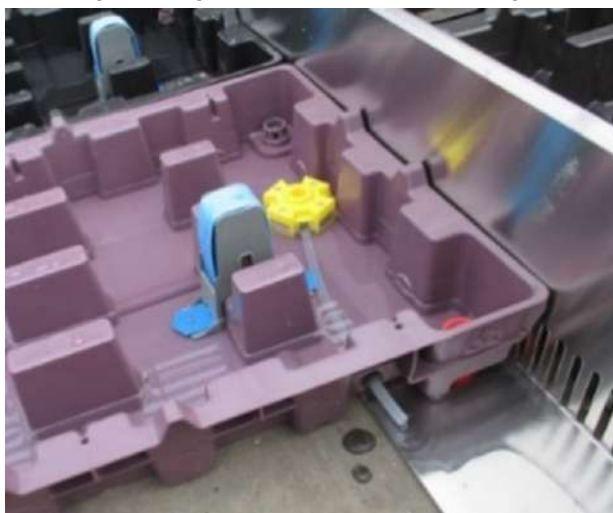
Figure 6. Régulateur à 4 sorties calibrées dont l'une est connectée à un tuyau souple de vidange de l'eau de la zone de bacs concernés.
