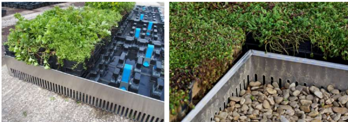
Figure 21. Pose des équerres ajourées en pourtour
