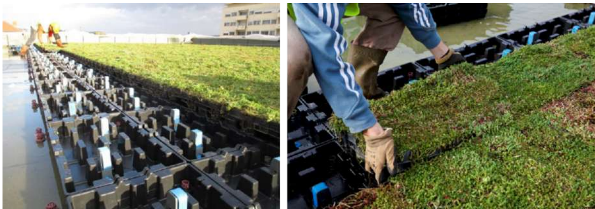
Figure 20. Progression en ligne de la pose des bacs HYDROPACK® sur les bacs HYDROSTOCK
