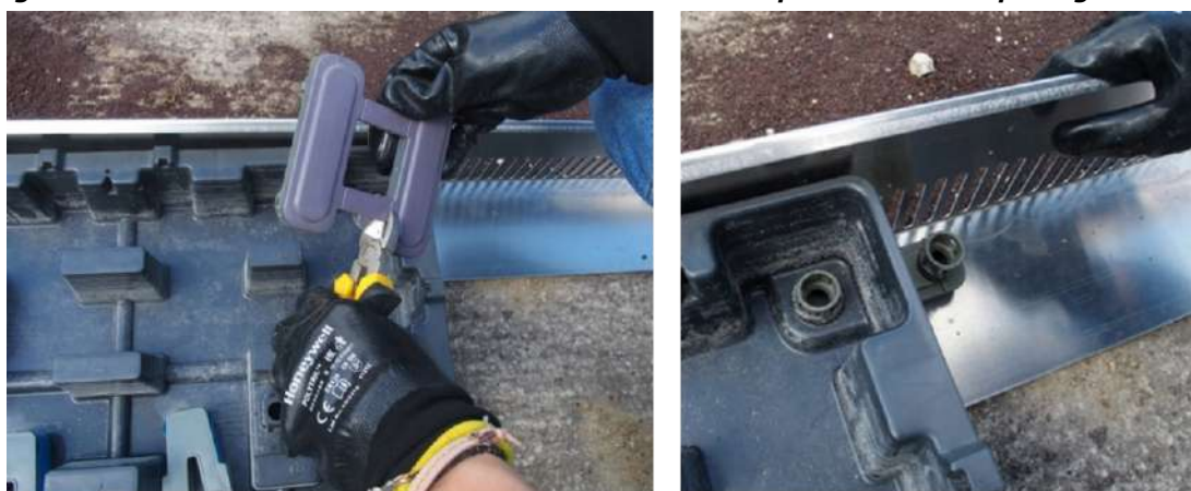
Figure 19. Découpe d'un connecteur à 4 branches pour constituer un connecteur à une branche, puis pose sur un bac en bordure d'une zone
