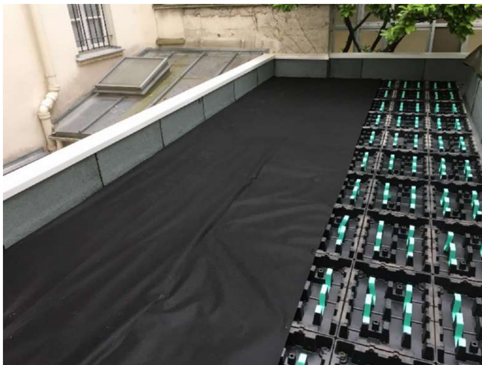
Figure 25. Couche filtrante : superposition des lés et agrafage
