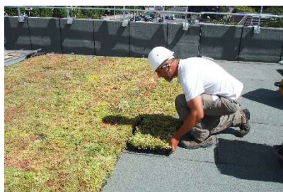
Mise en œuvre Bac HYDROPACK®
