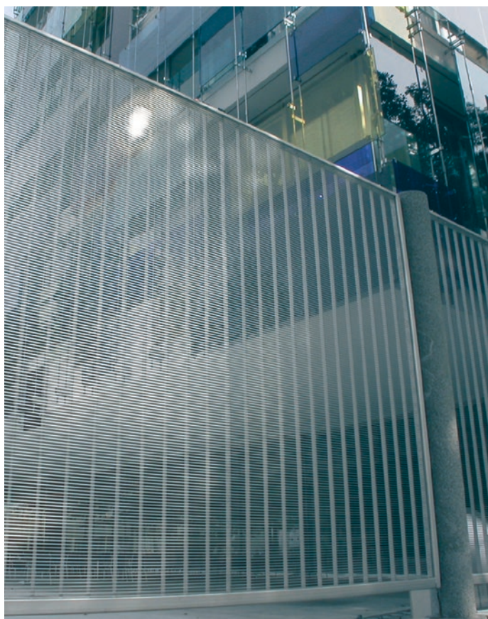
Barrière de sécurité
