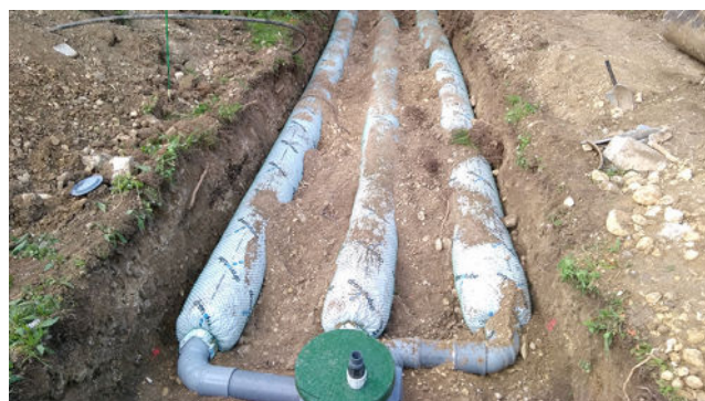
Installation d'une station compacte suivie d'un système drenotube® - Nice, France
