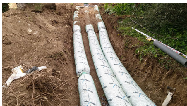
Installation d'une station compacte suivie d'un système drenotube® - Nice, France
